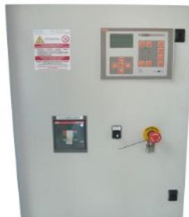
Centralina RGK800 con multimetro (voltmetro, amperometro, frequenzimetro, contaore e voltmetro batteria). Caricabatteria, funzione test periodico e riferimenti di rete. Moduli di espansione EXP ed ingresso analogico programmabile.
