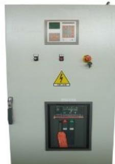
Centralina RGK800 con multmetro (voltmetro, amperometro, frequenzimetro, contaore e voltmetro batteria). Caricabatteria, funzione test periodico e riferimenti di rete. Moduli di espansione EXP ed ingresso analogico programmabile.
