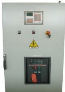
Centralina RGK800 SA con multmetro (voltmetro, amperometro, frequenzimetro, contaore e voltmetro batteria).
